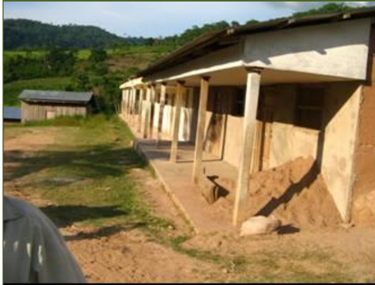
Fotografía N° 07: Caserío de Yanayacu, observar el material con que han sido construido las casas, que en general son de tapial o madera, material que abunda en la zona.
