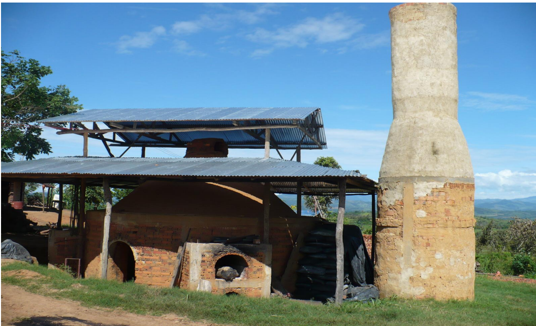
Foto N°02: Se observa el horno de quema de ladrillos y las instalaciones de procesamiento de la arcilla
