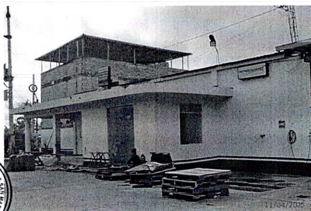
Fotografía N° 9 Zona de cambio de aceite y cuarto de limpieza
