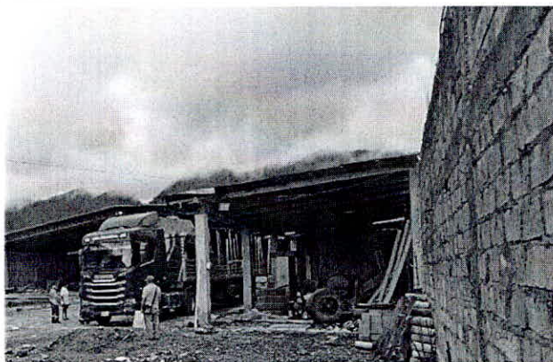
Fotografía N° 8 Zona de lavado y Depósito 3
