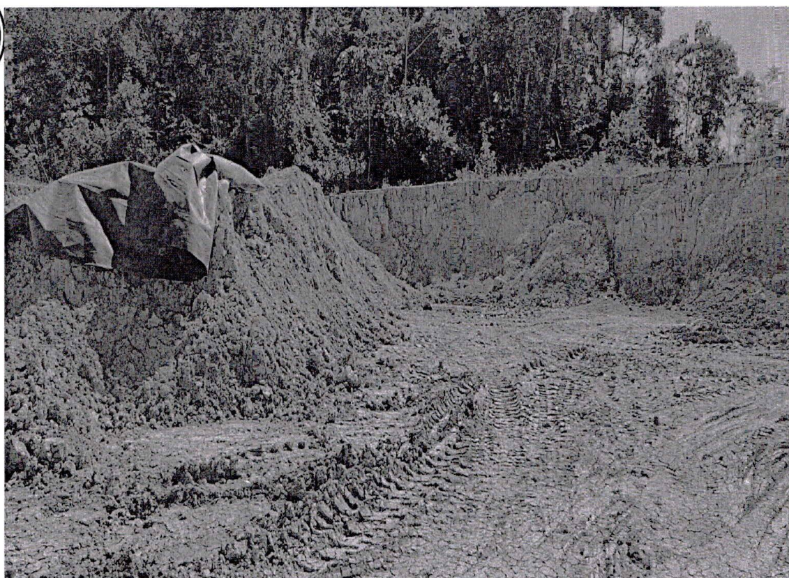
Fotografía N° 4: Vista de material acumulado en la zona de explotación.
