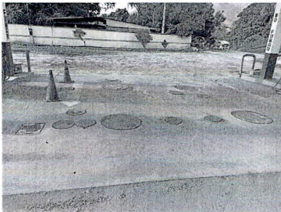
Fotografía N° 1 Zona de tanques de combustibles líquidos
