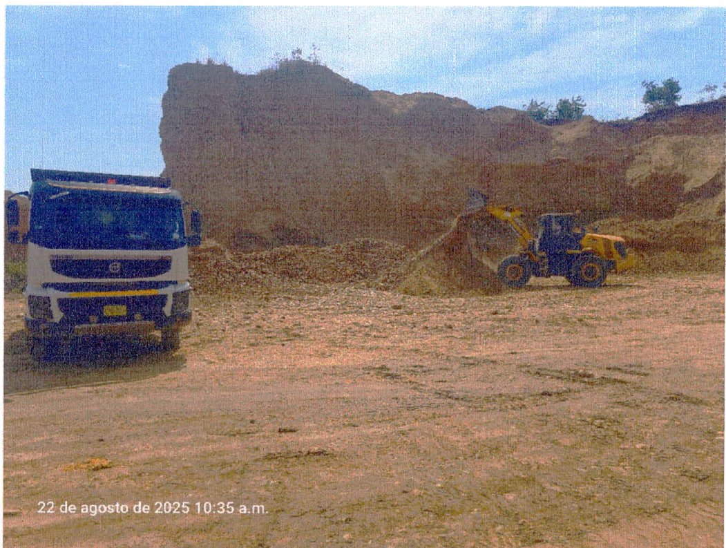
Fotografía N° 4 Vista fotográfica de la fiscalización especial.
