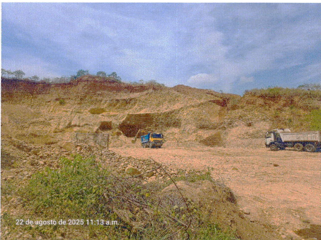
Fotografía N° 6 Vista fotográfica de la fiscalización especial.
