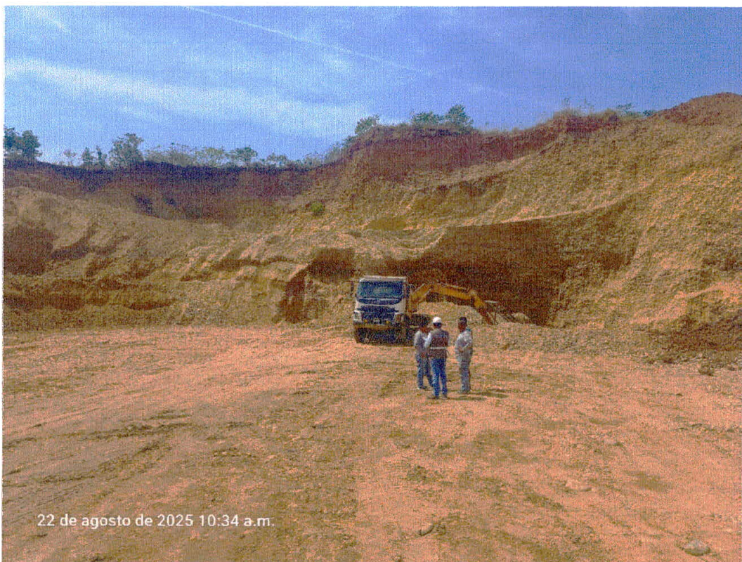
Fotografía N° 2 Vista fotográfica de la fiscalización especial.
