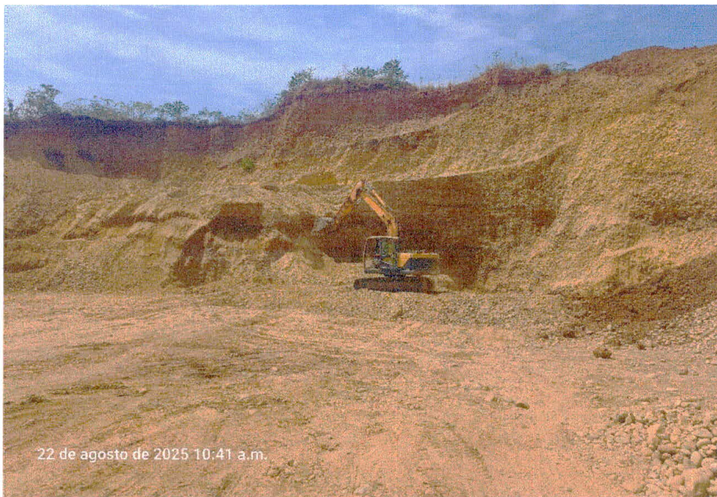
Fotografía N° 5 Vista fotográfica de la fiscalización especial.
