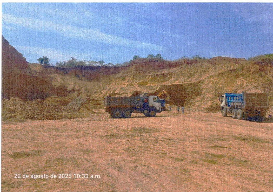
Fotografía N° 3 Vista fotográfica de la fiscalización especial.
