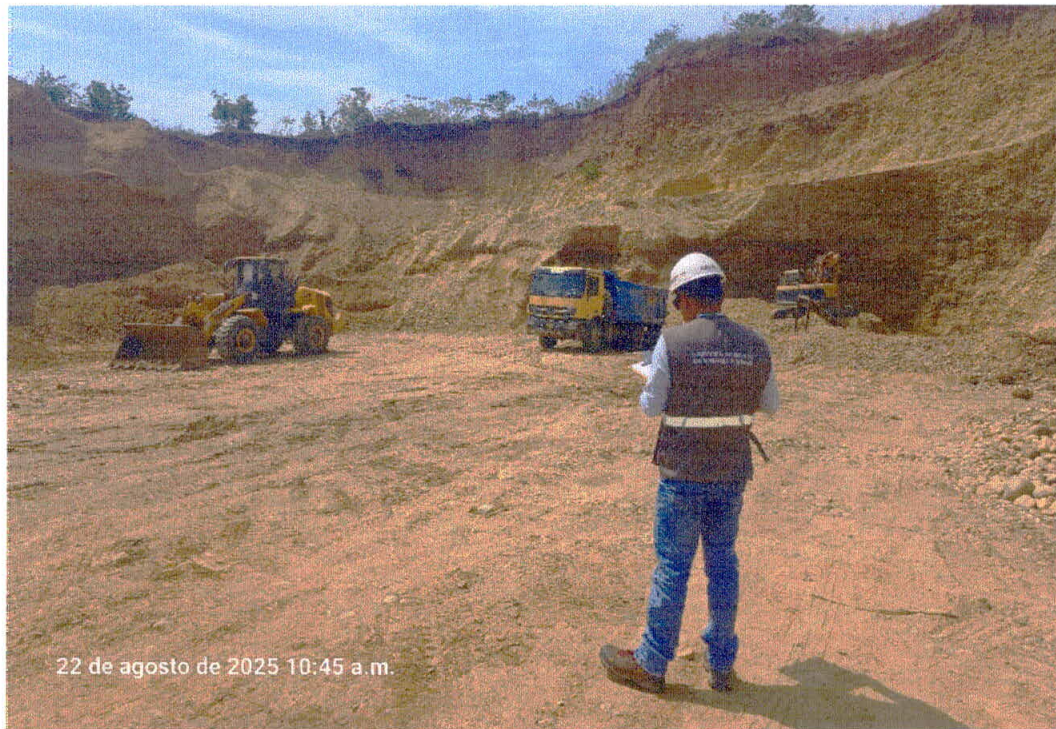
Fotografía N° 1 Vista fotográfica de la fiscalización especial.
