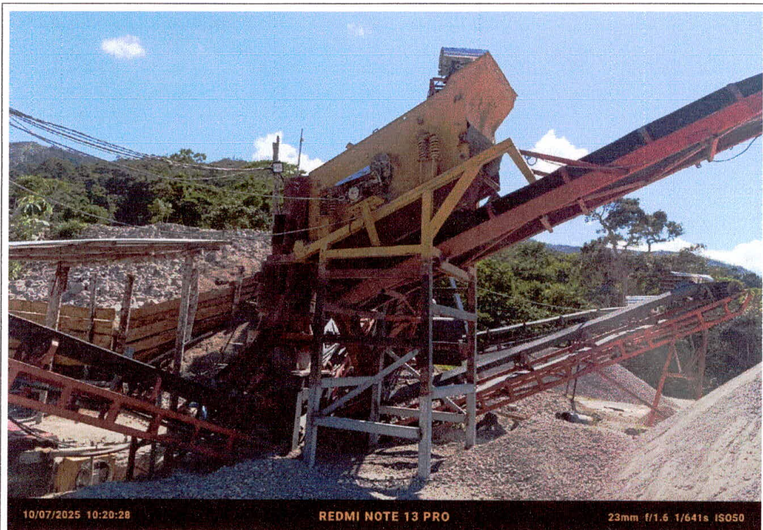
Fotografía N° 3 Vista fotográfica de la supervisión especial.
