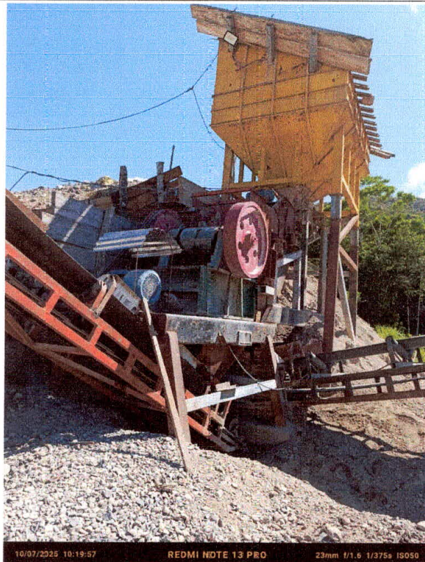
Fotografía N° 2 Vista fotográfica de la supervisión especial.
