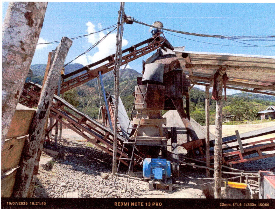
Fotografía N° 4 Vista fotográfica de la supervisión especial.
