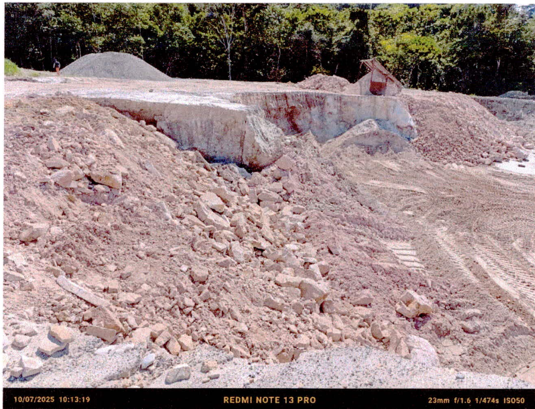
Fotografía N° 12 Vista fotográfica de la supervisión especial.
