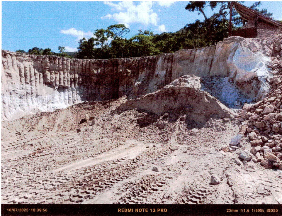
Fotografía N° 9 Vista fotográfica de la supervisión especial.
