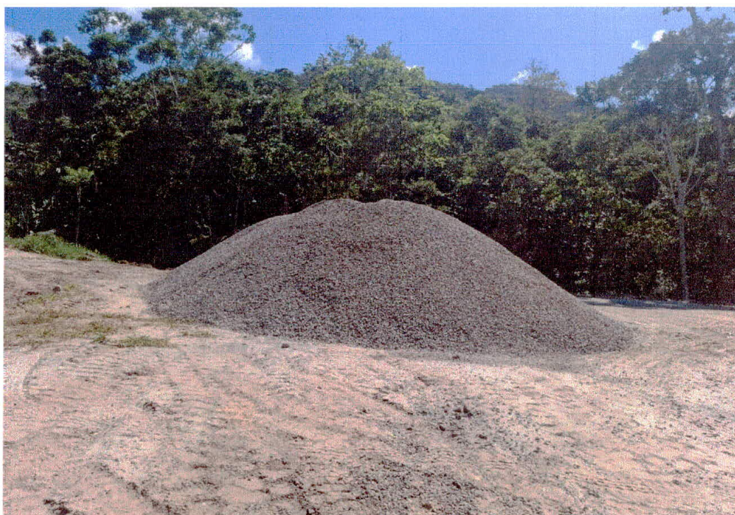
Fotografía N° 7 Vista fotográfica de la supervisión especial.
