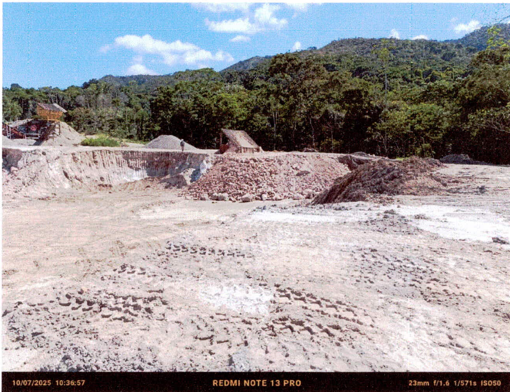
Fotografía N° 10 Vista fotográfica de la supervisión especial.
