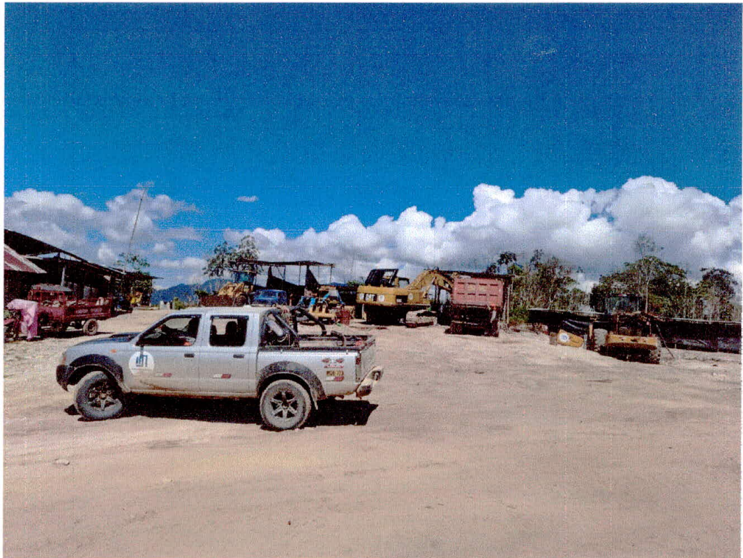
Fotografía N° 14 Vista fotográfica de la supervisión especial.
