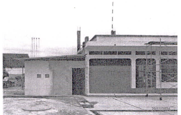
Fotografía N° 8 Edificación – Secretaria, contabilidad y cocina
