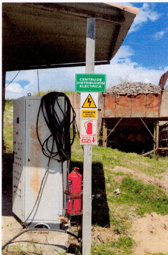
Fotografía N° 1: Vista de la inspección de verificación.
