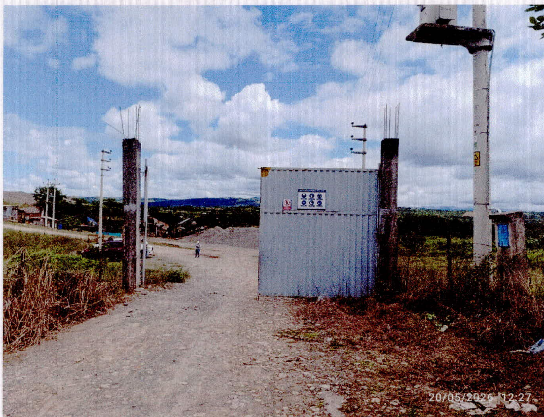
Fotografía N° 7: Vista de la inspección de verificación.
