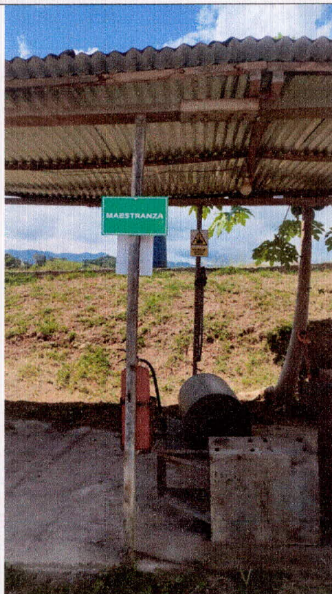
Fotografía N° 3: Vista de la inspección de verificación.
