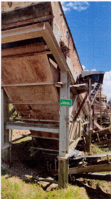
Fotografía N° 5: Vista de la inspección de verificación.
