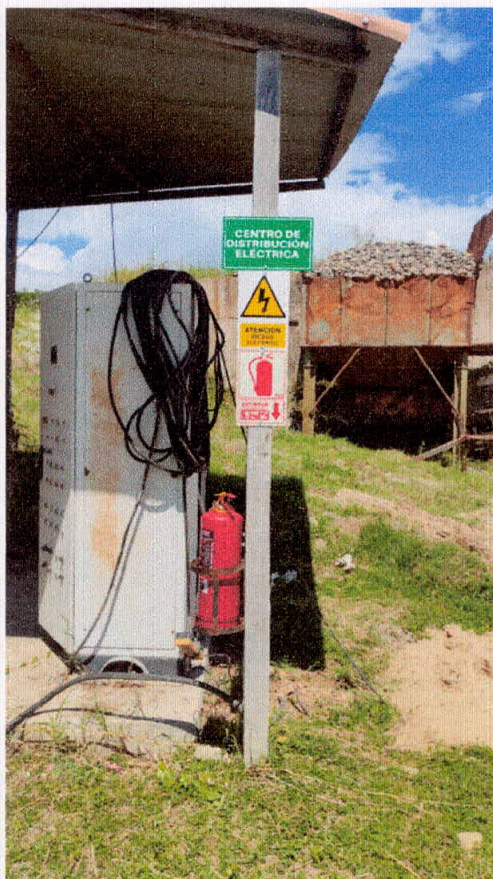
Fotografía N° 4: Vista de la inspección de verificación.
