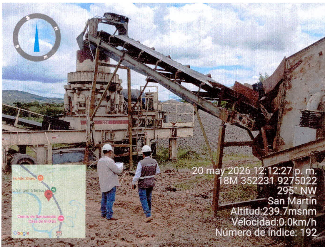
Fotografía N° 14: Vista de la inspección de verificación.
