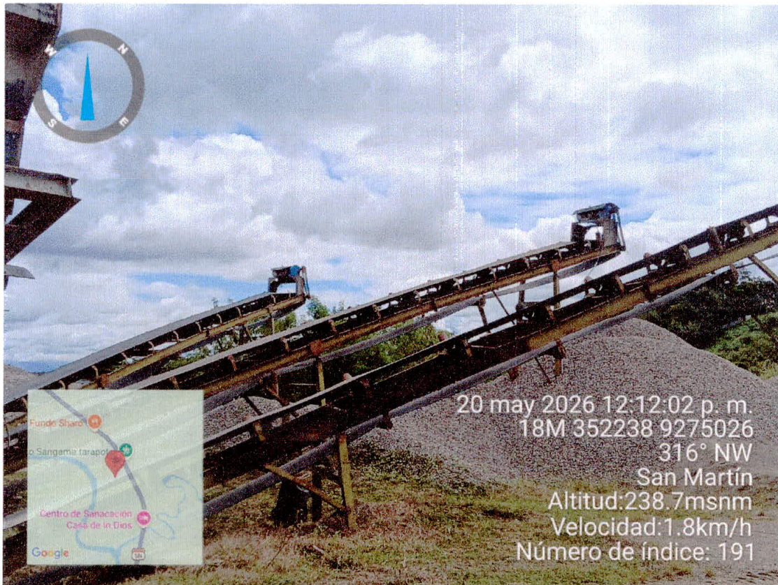
Fotografía N° 10: Vista de la inspección de verificación.
