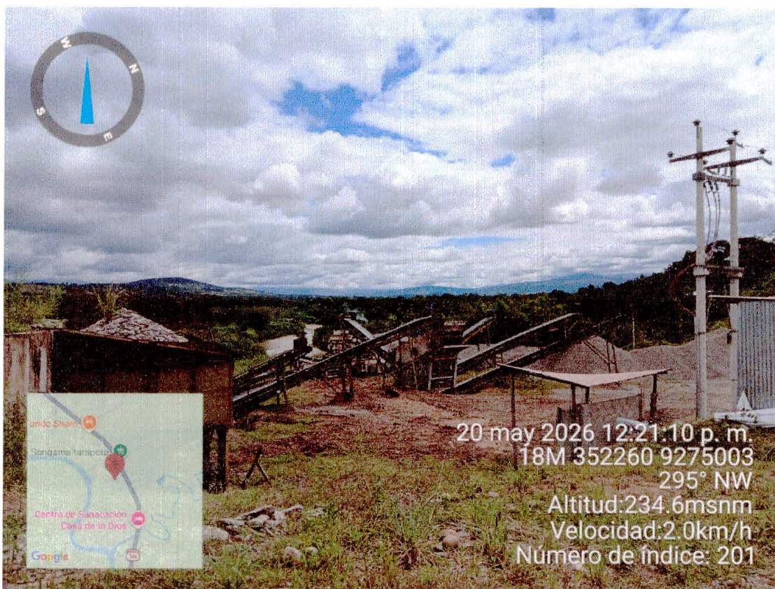
Fotografía N° 12 Vista de la inspección de verificación.
