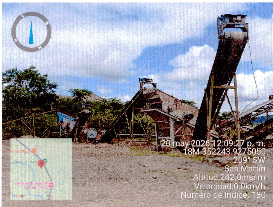
Fotografía N° 16 Vista de la inspección de verificación.
